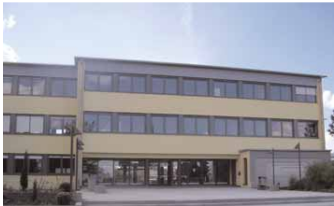
Die Sanierung des Schulhauses in Reichertshofen wird noch einige Zeit in Anspruch nehmen und damit auch den neuen Gemeinderat in Punkto Finanzierung weiterhin beschäftigen. (sc)
