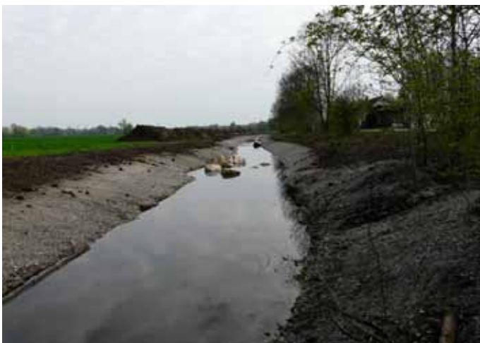
Die Engstelle am Moosgraben in Braullach - Höhe Aretinstraße - ist beseitigt. Der Bach wurde entsprechend verlegt.
