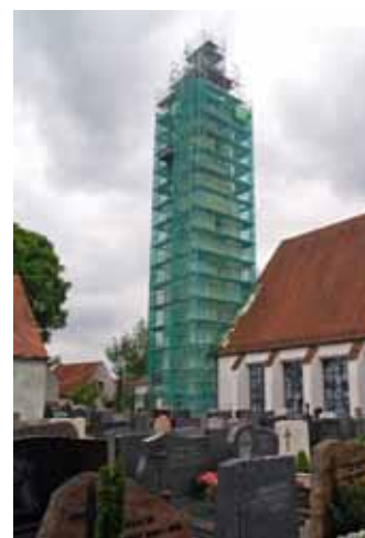
Kirchturm wird general-saniert. (scl)
